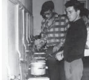
Gemeinschaftsküche im Wohnheim
