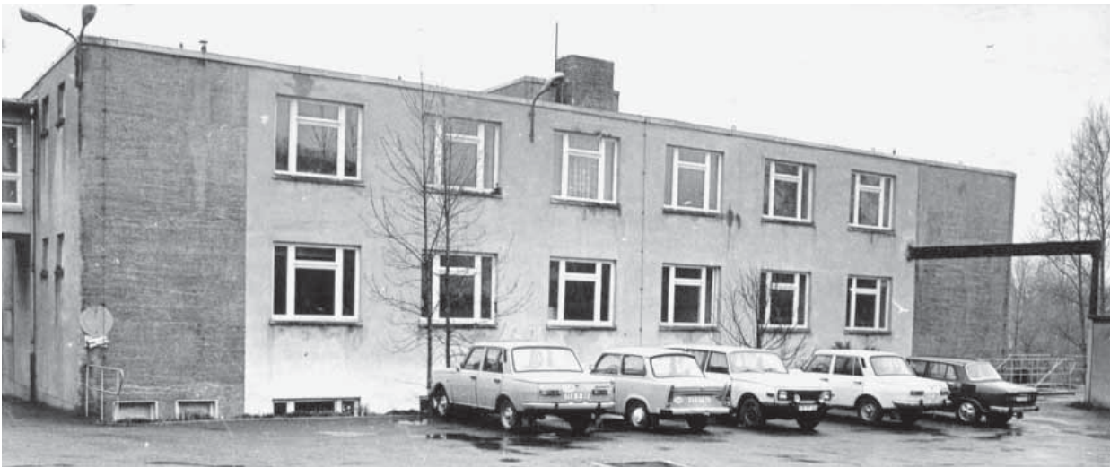
Das neuerrichtete Laborgebäude
